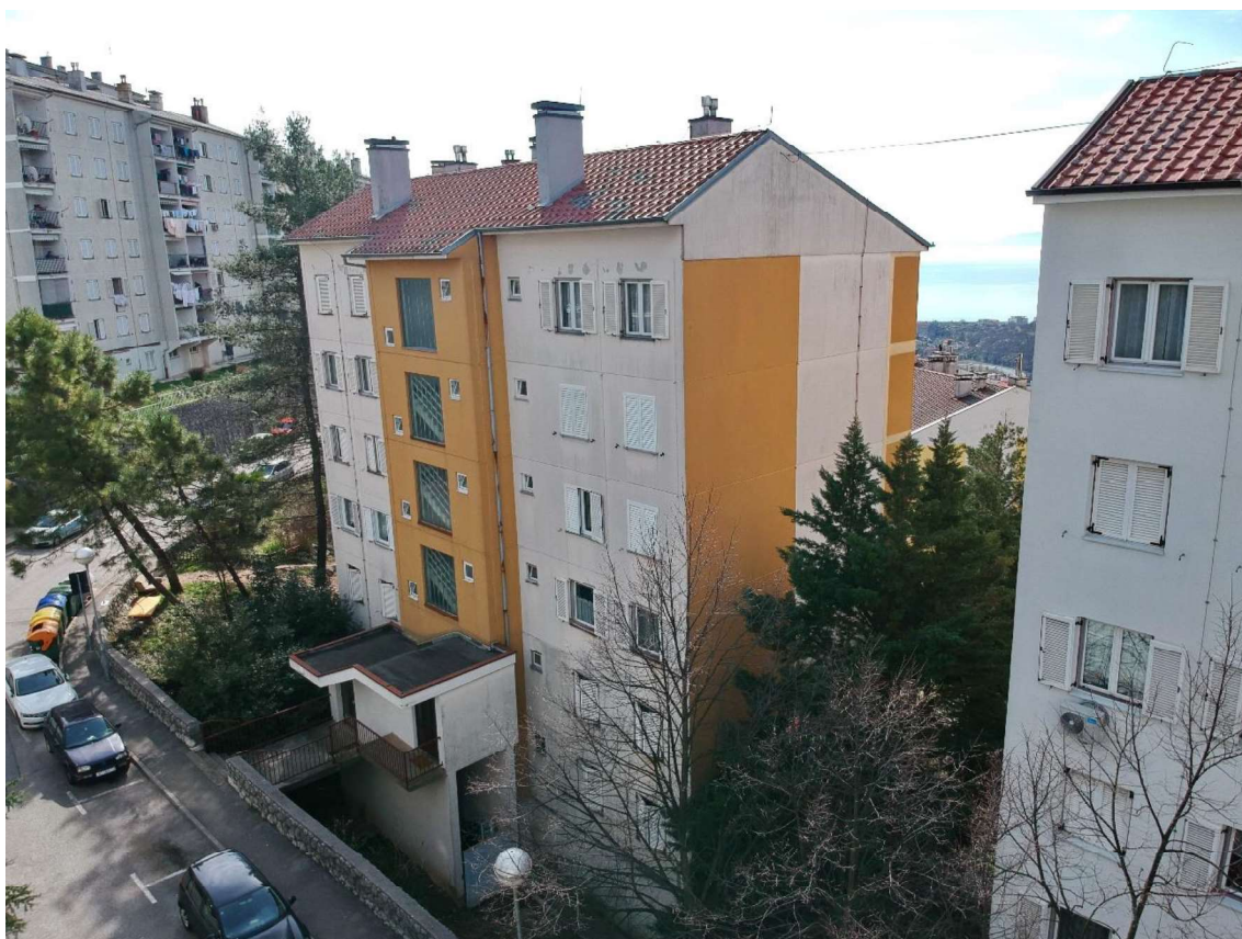
Slika 4 – Sjeverno i zapadno pročelje
