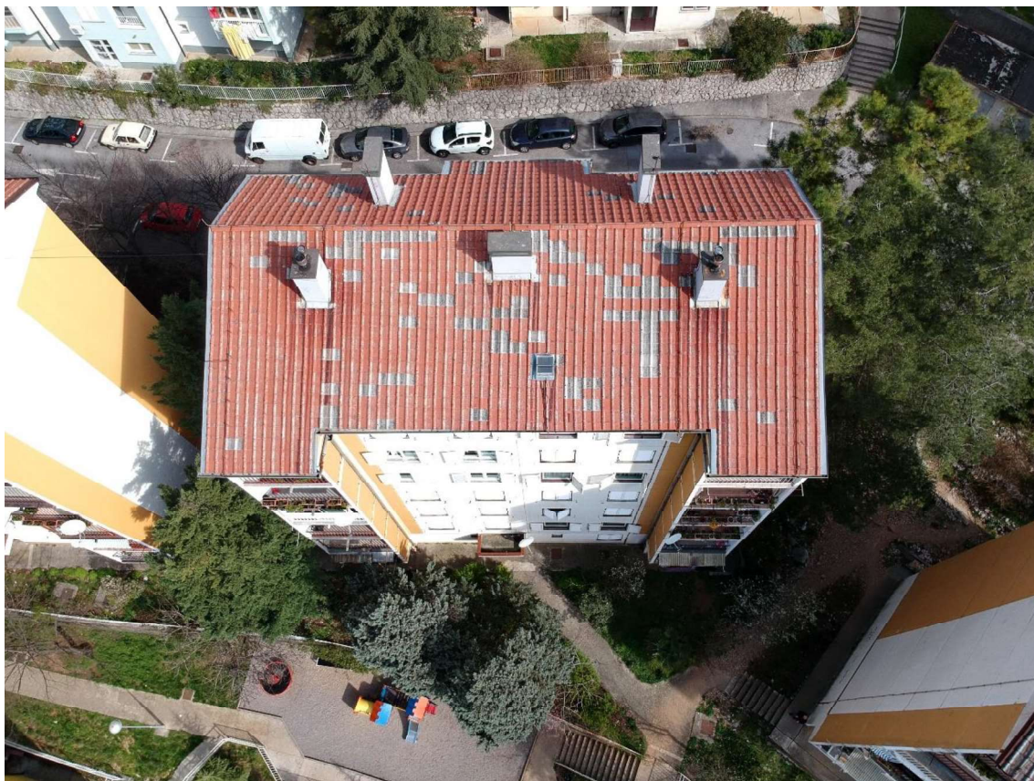
Slika 6 – Pogled na krov
