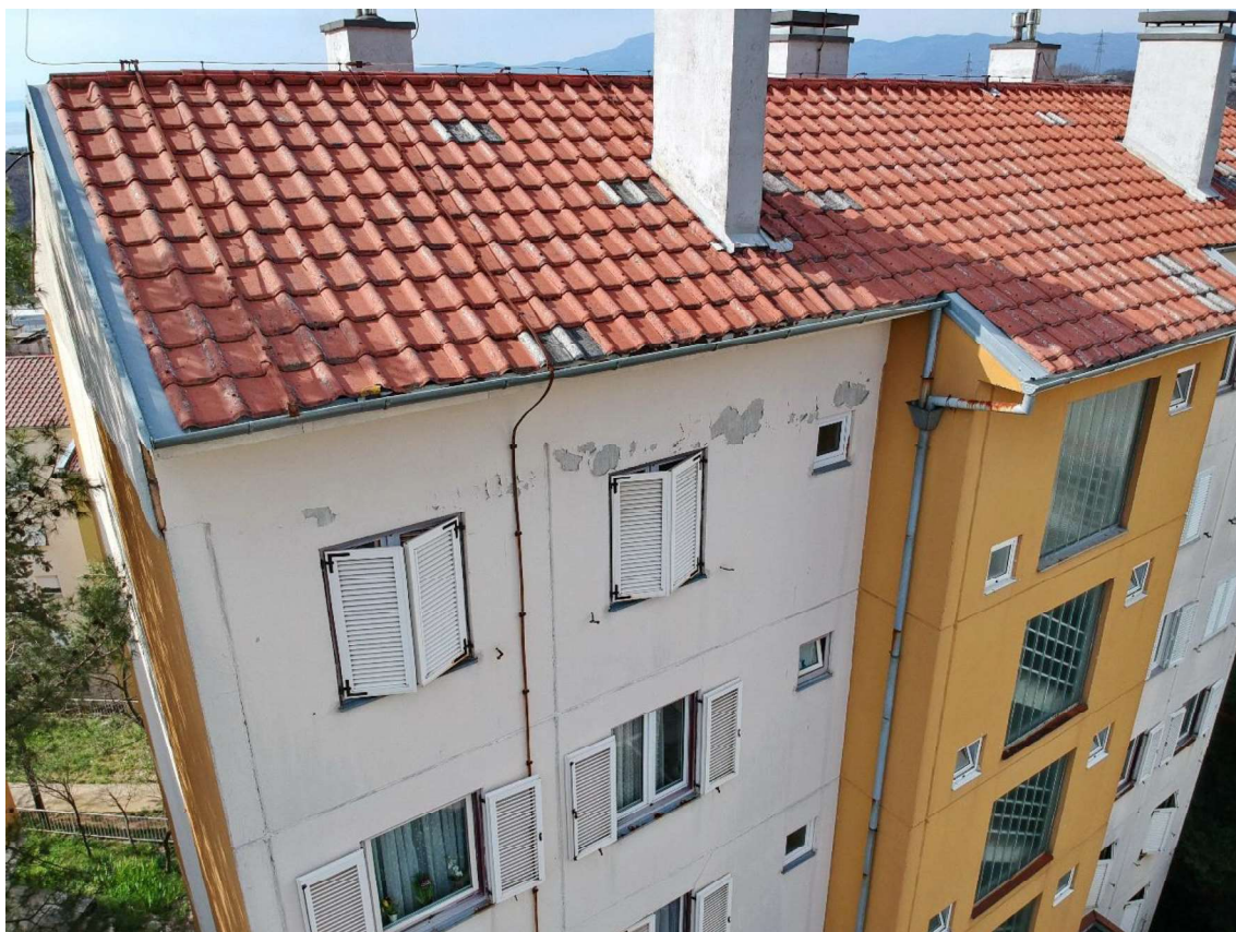
Slika 3 – Detalj sjevernog pročelja
