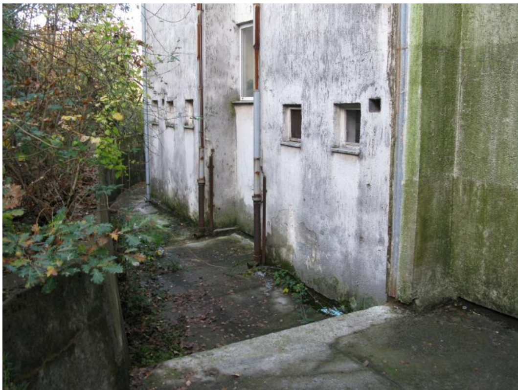
Sl.5. Utjecaj atmosferilija na sjvernom pročelju
