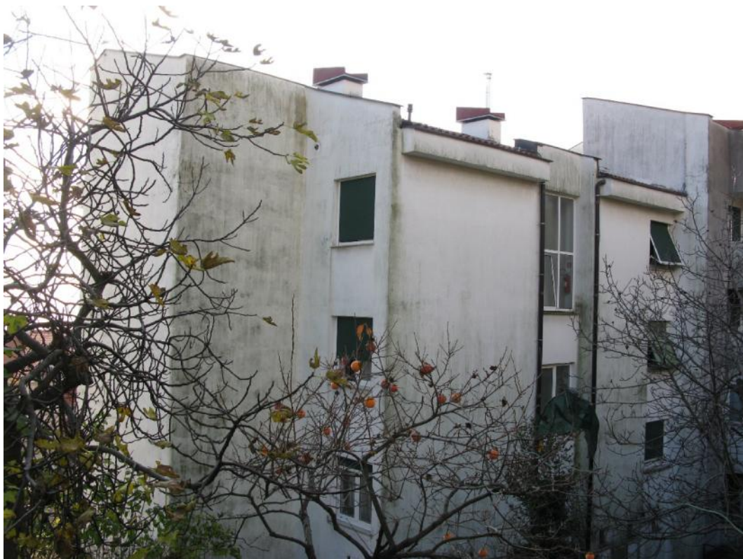
Sl.4. Dio sjevernog i istočnog pročelja
